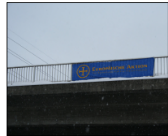
Andere Transparente an diversen Autobahnbrücken in der Ostschweiz!
